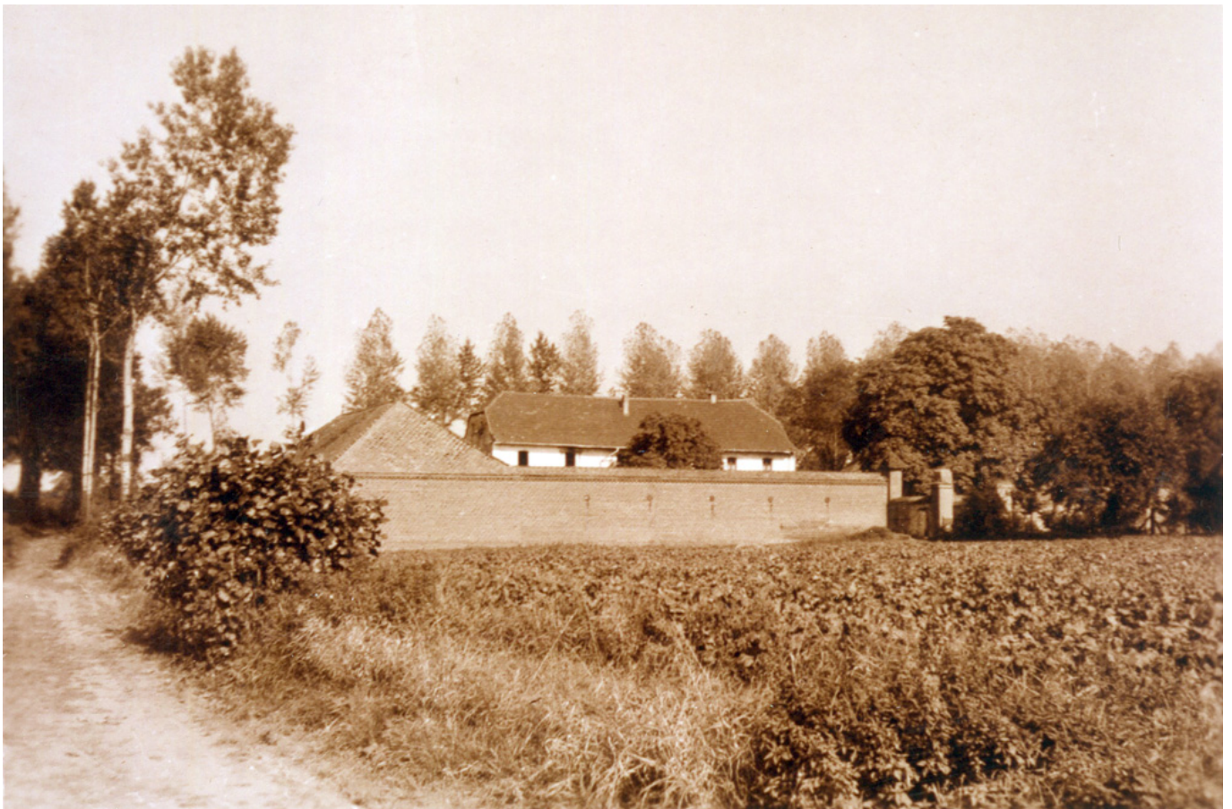
— Vorst, Kaarst, Am Holzbüttger Haus; Das Holzbüttger Haus liegt südlich des Nordkanals am Rande des
