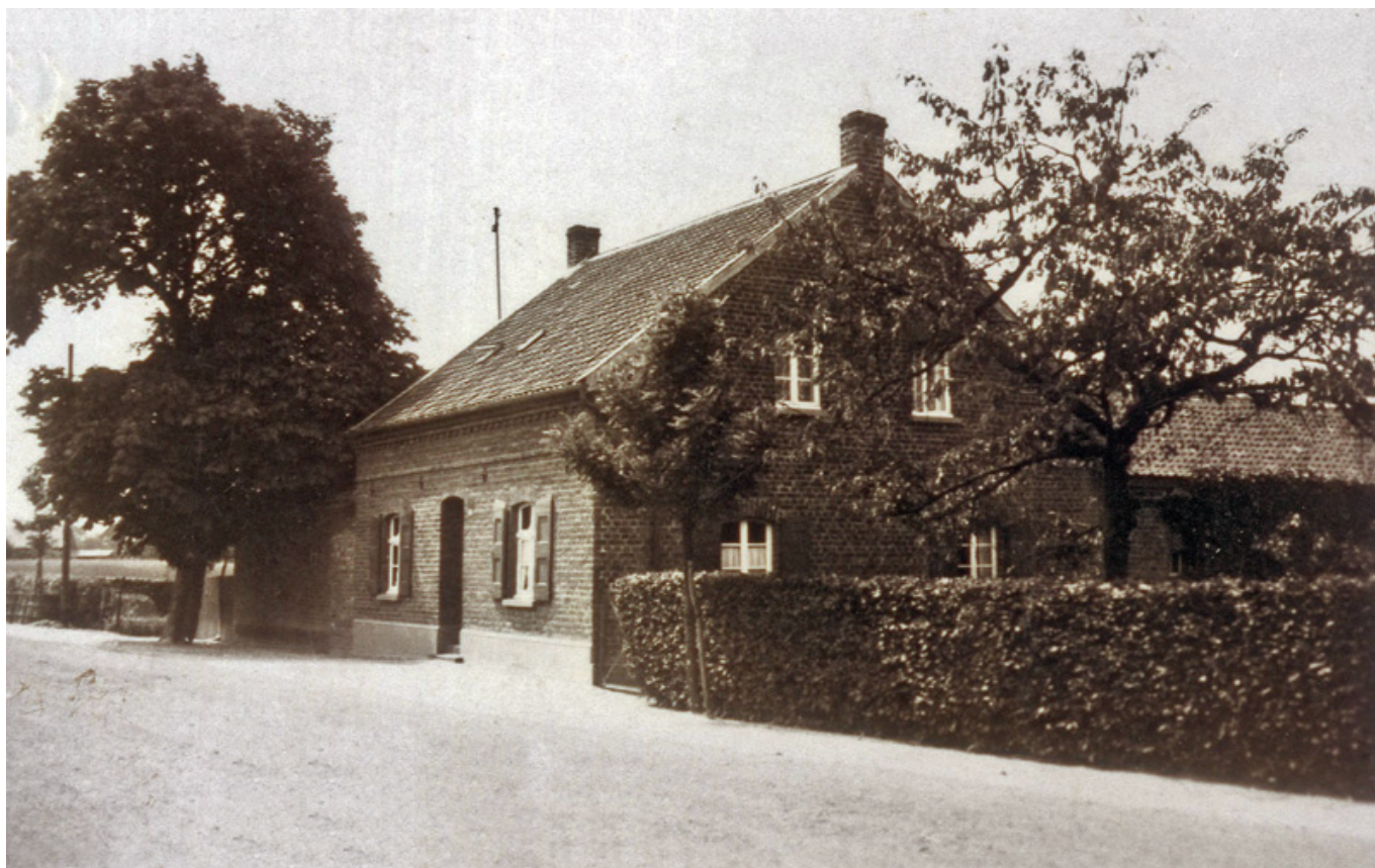
Das Haus der Bäckerei Schop 1939 mit dem im Text erwähnten Kastanienbaum (StA Kaarst D3-3-100).
